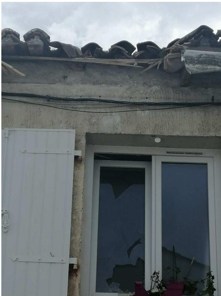
Figure 7 : habitation endommagée par la chute de la partie haute de la dérive de l'équipier
